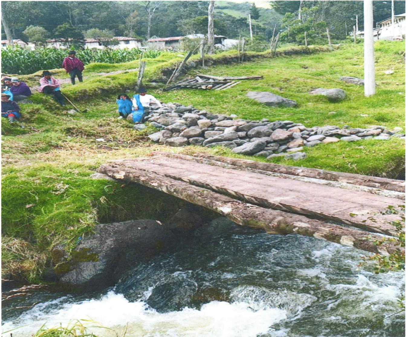
Inicios de los trabajos.
